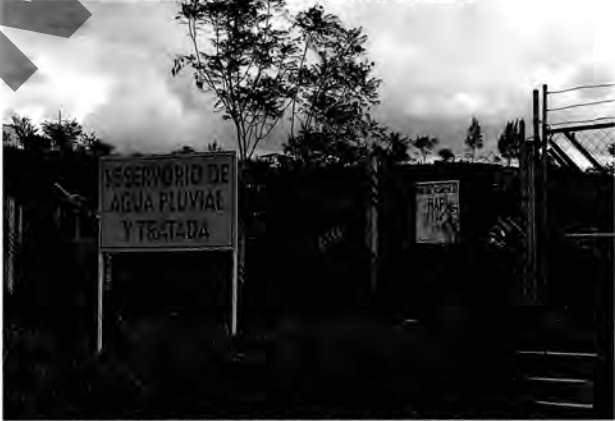
Imagen 5. Reservorio de agua pluvial y tratada
